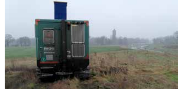
Het draagvermogen van de ondergrond is onderzocht.
