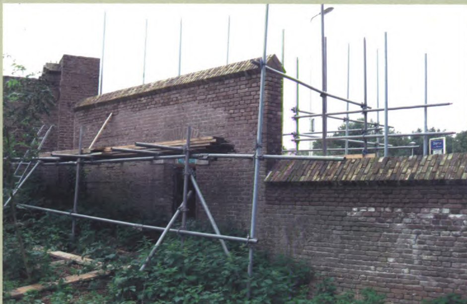
De Koningsmuur langs de Doesburgse dijk staat in de steigers.
