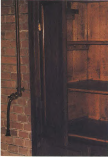
Een 'hydraulische lift' met links de spreekbuis. Tegenwoordig wordt de lift elektrisch aangedreven.
