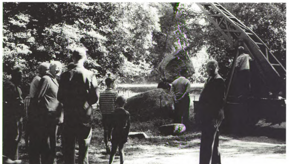
Het plaatsen van de zwerfkei in 1959 door de firma Van Wezel uit Hengelo.
