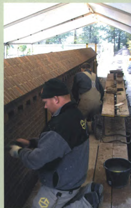
Het metselwerk wordt op dezelfde wijze uitgevoerd als het originele.
