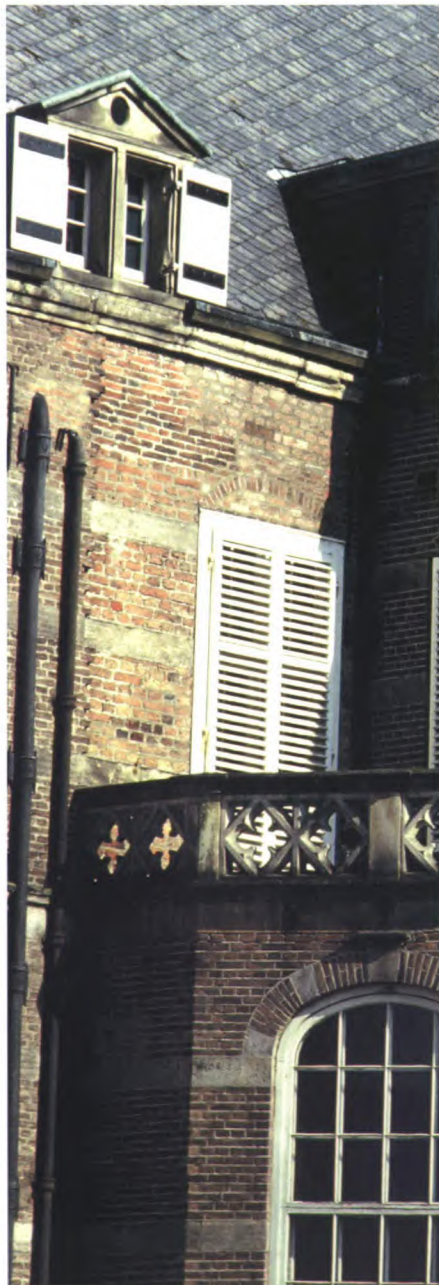
Het water uit de ventilator werd via een aansluiting op de regenpijp in de gracht geloosd.
