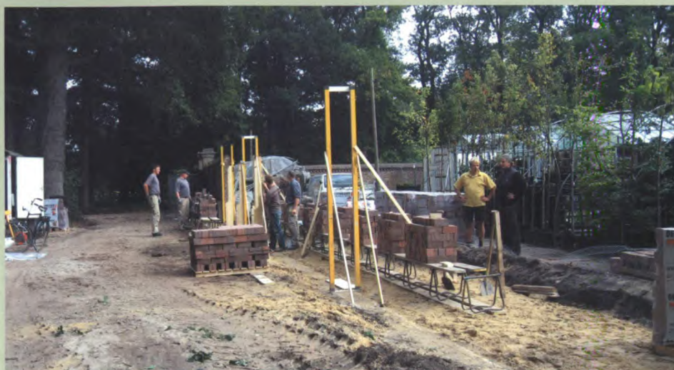
Het begin van de werkzaamheden.
