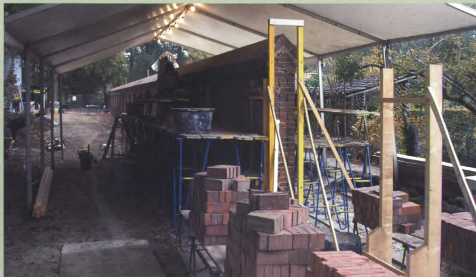
Door de overkapping kon er ook bij slecht weer worden doorgewerkt.
