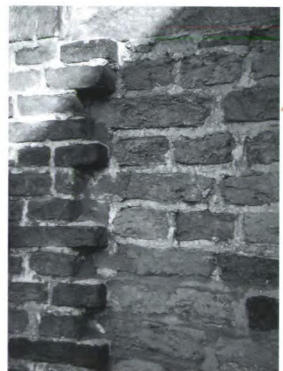
Detail van de metselnaad met hoekverband.
