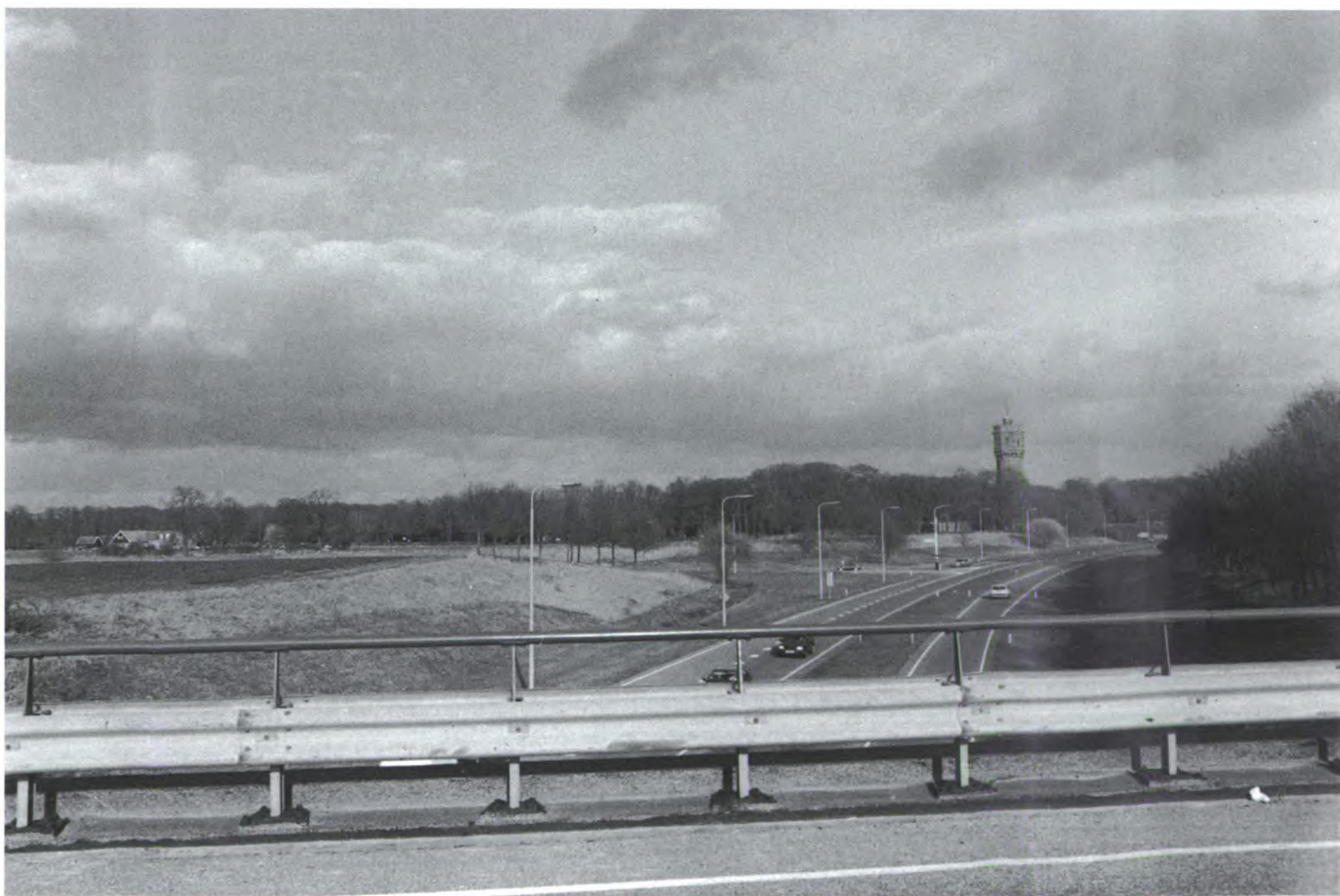
De Rondweg Delden die het kasteel afsnijdt van de historische kern van Delden.
