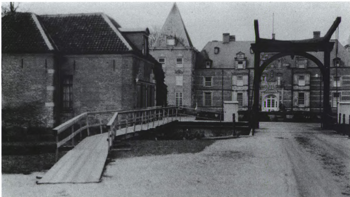
In 1926 werd de vaste brug over de buitengracht vervangen door een ophaalbrug. Tijdens de werkzaamheden behielp men zich met een noodbrug. Foto uit het album van M.A.M.A. van Heeckeren van Wassenaer, 1926.
