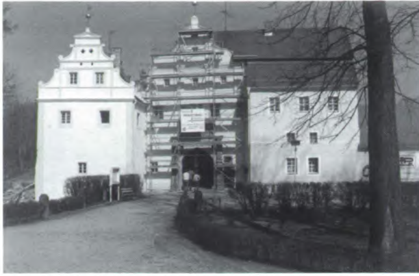
Van het Schloss Sonnenwalde zijn na de oorlog nog enkele bijgebouwen blijven staan. Foto: Hans Hondebrink.
